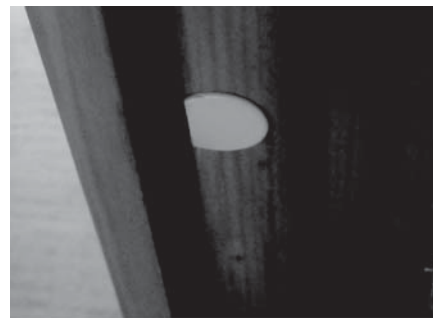
ホールキャップは、取り付け時に枠に合わせてカットが必要になります。
