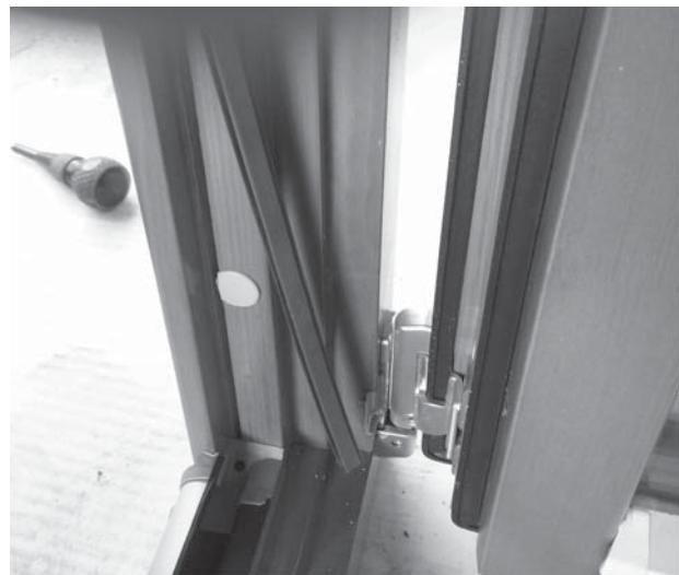
ホールキャップは、取り付け時に枠に合わせてカットが必要になります。
