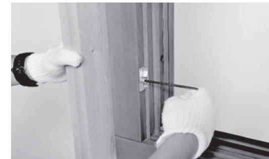
六角レンチで枠を調節します。
